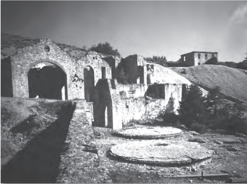
Laverie de plomb de St-Cierge-la-Serre. Successivement on remarque : les tables de Linckenbach, les bâtiments abritant les machines avec leurs ouvertures pour les axes ou les courroies, le terril. © C. Nace
