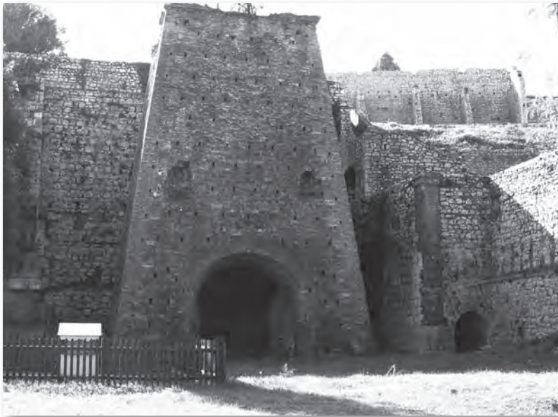
Un des hauts fourneaux de La Voulte. © C. Nace
