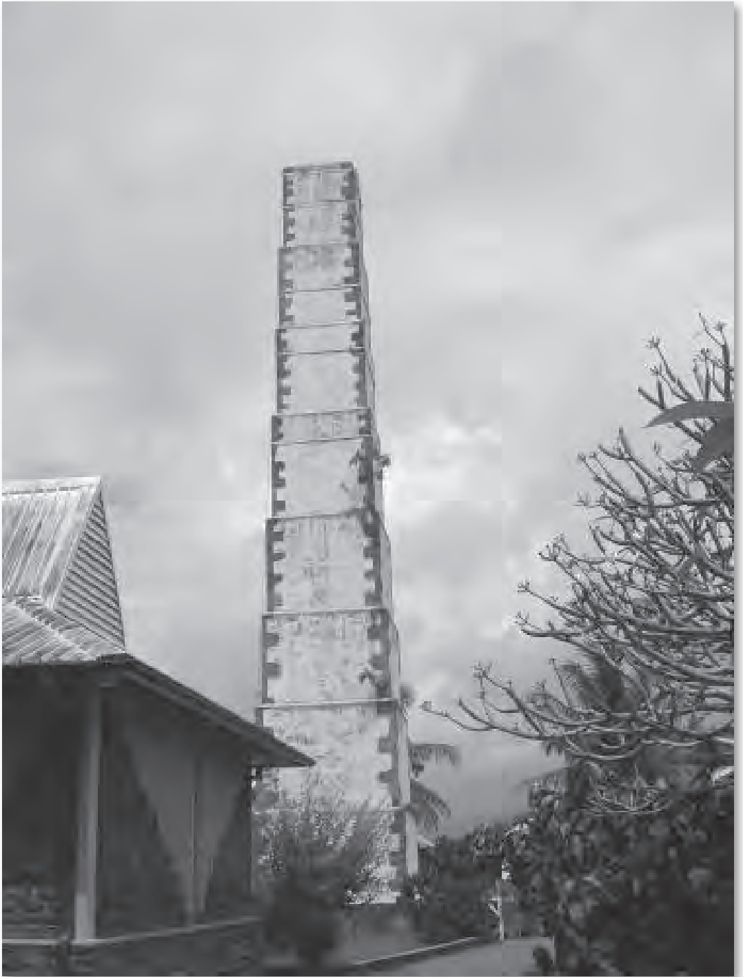
Cheminée de l'usine de Dzoumogné. © L. Lachery
