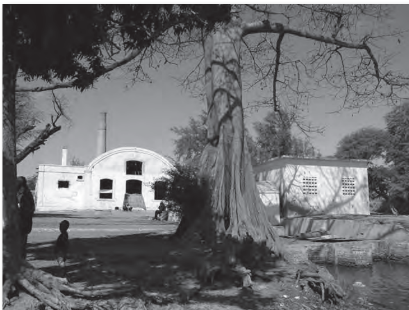
La station de pompage de Mbakhana (Sénégal) Installée par les français pour approvisionner la ville de Saint Louis en eau douce, elle subsiste comme curiosité, détachée de son contexte © Gracia Dorel-Ferré (2004)
